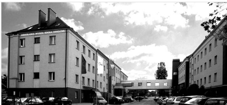
Budynki główne GWSH w Katowicach-Piotrowicach
