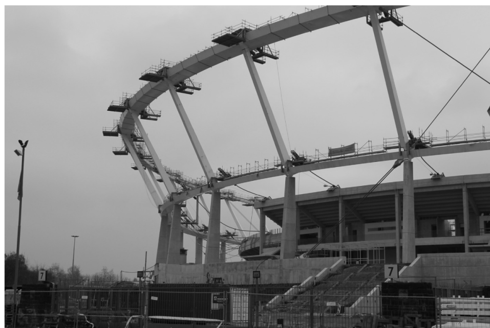
Fot. 8. Nowy szkielet Stadionu Śląskiego w budowie (fot. Z. Śnieszko).
